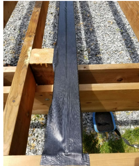
Membrane d'étanchéité lorsque les solives sont doublées
